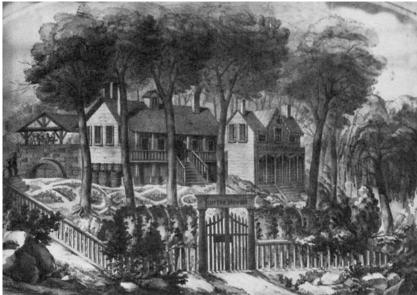
Fig. 6. Un disegno del cottage di Meucci e del vicino edificio della “Clifton Brewery,” realizzato dal pittore Nestore Corradi nel 1858
